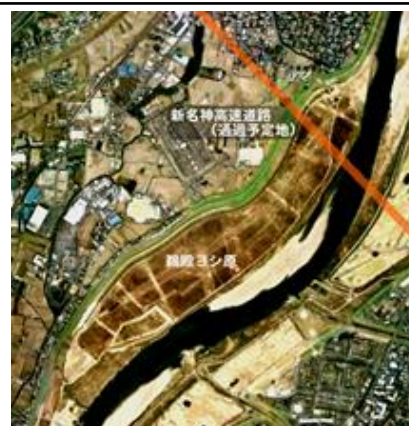
鶺殿の新名神高速道路建設予定ルート (赤線で示した箇所)
